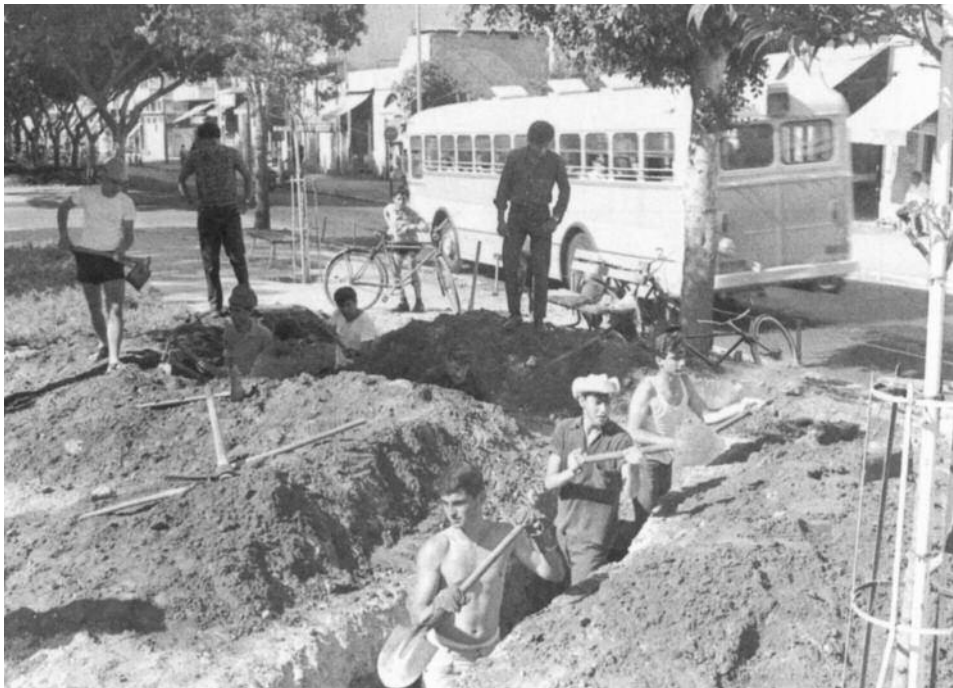
Tensa espera: ciudadanos israelíes cavan trincheras en espera de lo peor
