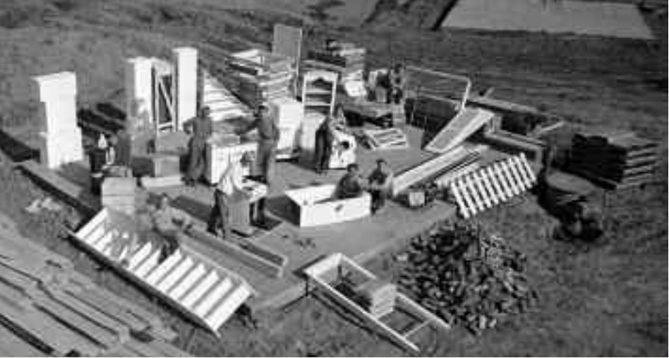
Línea de ensamblaje: todos los materiales y el personal necesario para construir una casa de Levittown, sobre la respectiva parcela (fuente: Universidad de Illinois)
